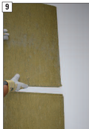
9 Obere Nutplatte in die Doppelfederplatte einstecken.
