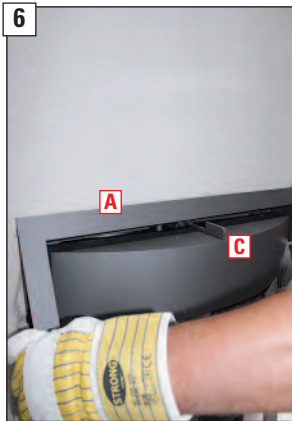
Verlängerten Abdeckrahmen A schräg angestellt zuerst über den Verbrennungsluftschieber C fädeln.
