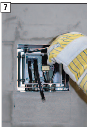
7 Vor der Montage des Blendrahmens kann das Gehäuse der Bedien-/Messeinheit bei Bedarf nachjustiert werden.
