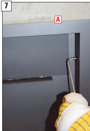
Verlängerten Blendrahmen A bis zur bauseitigen Verkleidung aufschieben und Befestigungsschrauben umlaufend festziehen.
