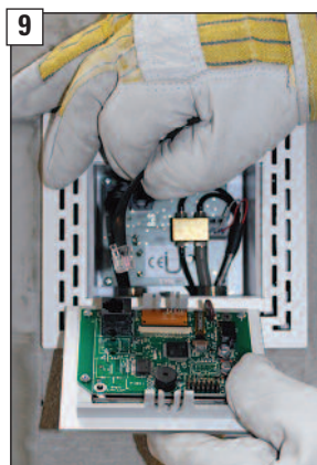
9 Steckverbindung mit der LUC-Displayeinheit verbinden.
