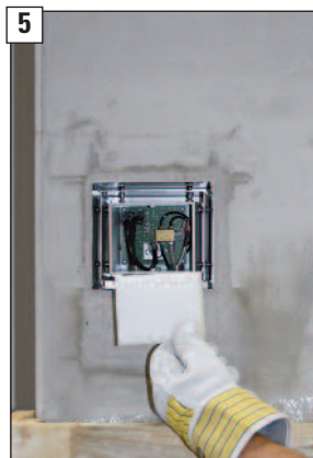
5 Schutzschwamm entfernen.
