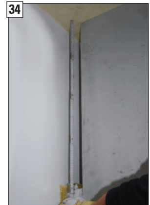
Differenzmaß zur bauseitigen Decke ermitteln.
