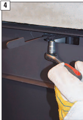
Befestigungsschrauben handfest anziehen.
