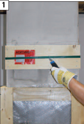
1 Äußere Transportschutzverpackung entfernen.
