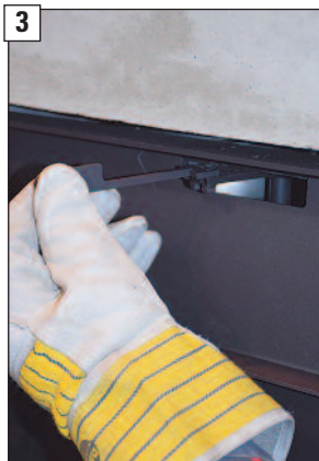
Verbrennungsluftschieber auf Befestigungsklemme aufstecken.
