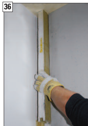
Obere Nutplatte in die Doppelfederplatte einstecken.
