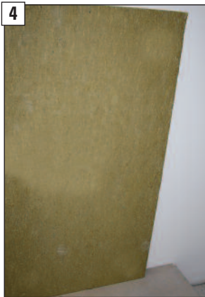
4 Untere Nutplatte des Spezial-KINGFIRE-Seitenwanddämmsets an der Innenwand befestigen.
