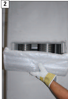
2 Konvektionsluftgitter aus der Montageöffnung entfernen.
