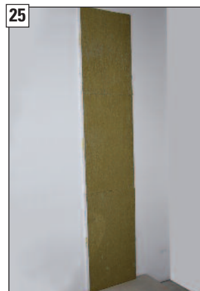
25 Fertigansicht vor Kranversetzen des KINGFIRE-Feuerstättenmantels.
