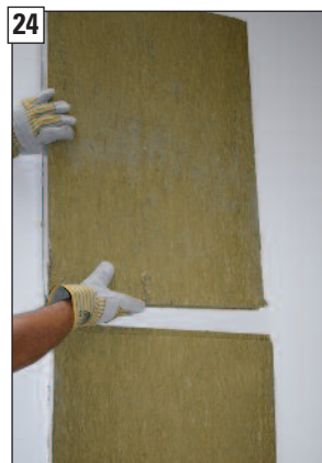
24 Obere Nutplatte in die Doppelfederplatte einstecken.
