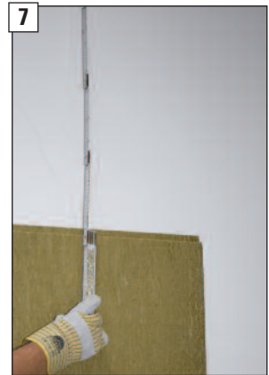
7 Differenzmaß zur bauseitigen Decke ermitteln.
