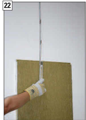
22 Differenzmaß zur bauseitigen Decke ermitteln.
