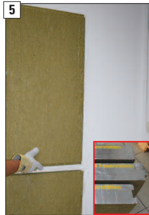
5 Doppelfederplatte in die Nutplatte einstecken und ...
