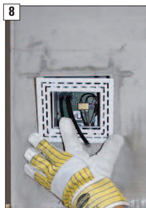
8 Blende mit Halteklammern auf das Gehäuse der Bedien-/Messeinheit aufstecken.
