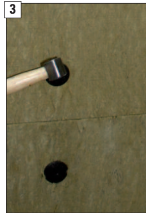
3 ... mit geeigneten Dämmstoffnägeln befestigt werden.
