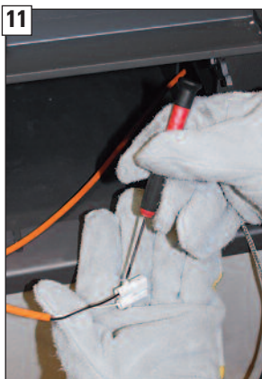
11 ... an der bauseitigen Zu- leitung gem. Anschluss- plan des Luftdruck- wächters verklemmen.
