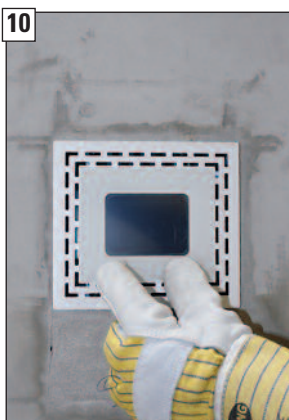
10 LUC-Grafikdisplay in der Steckverbindung des Gehäuses einrasten.
