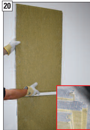
20 Doppelfederplatte in die Nutplatte einstecken und ...
