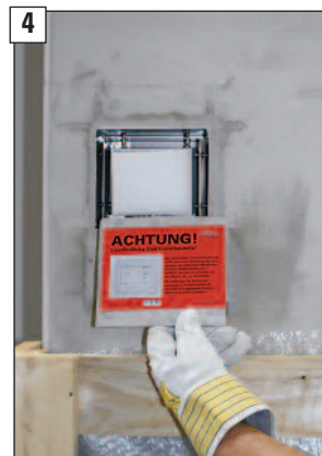
4 Innere Schutzabdeckung entfernen.
